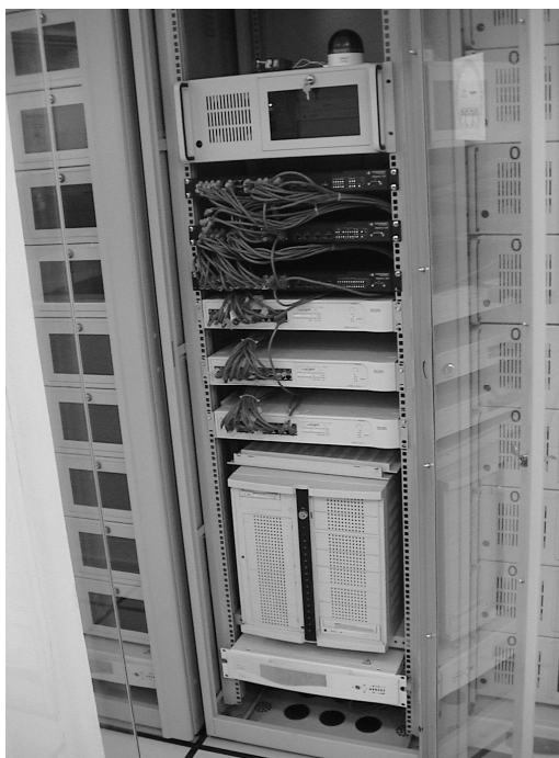
Figura A.3 - De cima para baixo: nó de controle, switches Gigabit (pretos), switches 100Mbit (brancos), servidor de backup e no-break.
